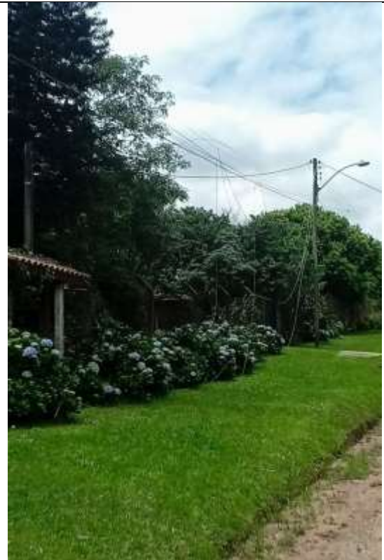
Foto 6 - Condutores arreventados devido ao evento em Eldorado do Sul (2023-848938)
