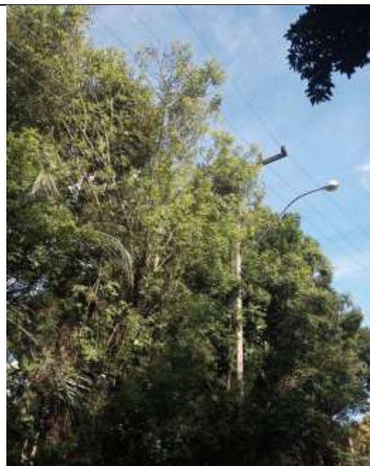
Foto 4 – Galhos sobre a rede devido ao evento em Viamão (2023-853267)
