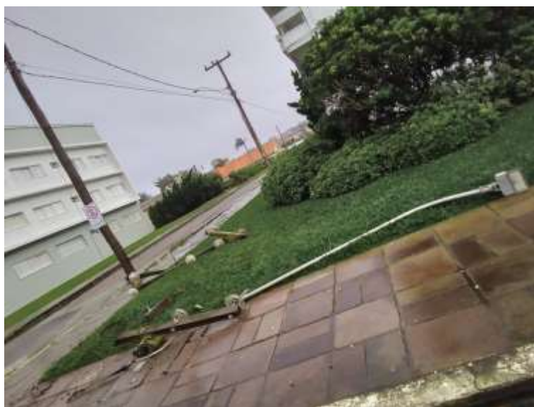
Foto 3 – Poste quebrado devido ao evento em Xangri-la (2023-851512)
