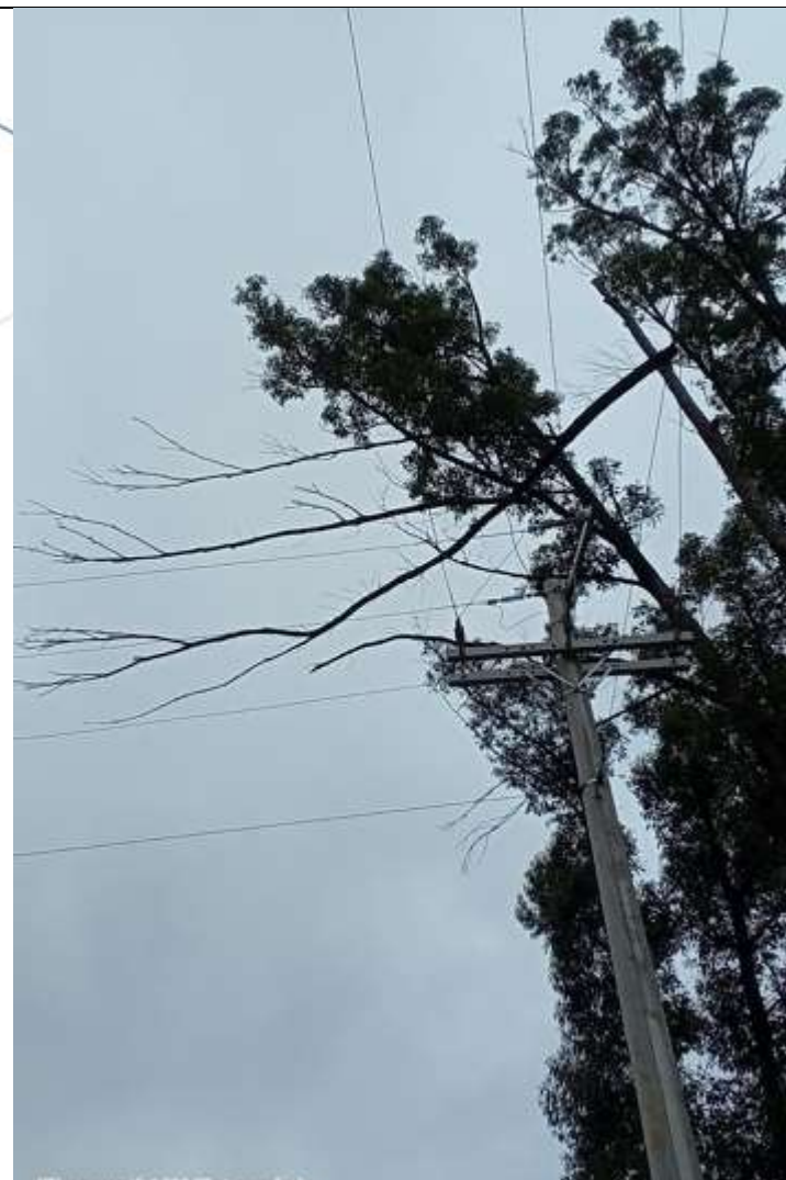
Foto 9 - Galho sobre a rede devido ao evento em Encruzilhada do Sul (2023-832064)
