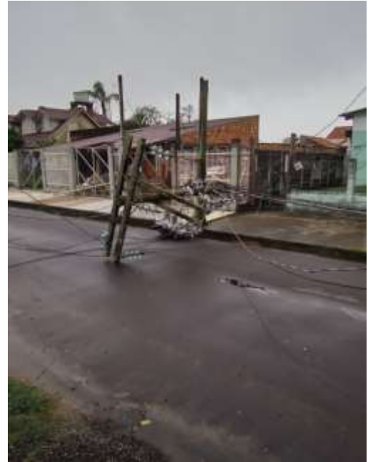
Foto 6 – Poste caído devido ao evento em Capão da Canoa (2023-834198)
