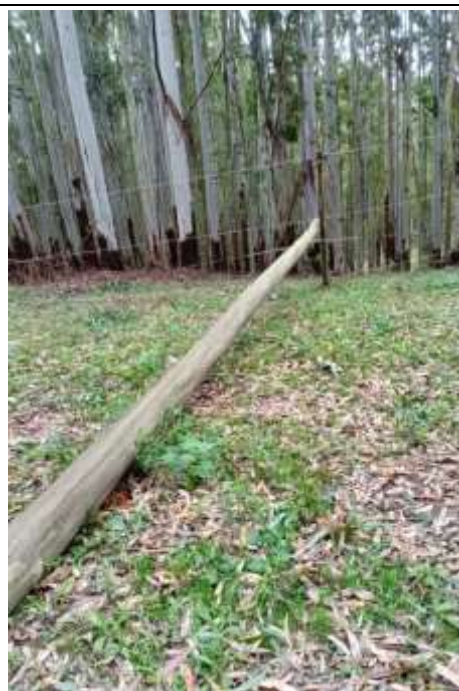
Foto 4 – Poste caído devido ao evento em Candiota (2023-831764)
