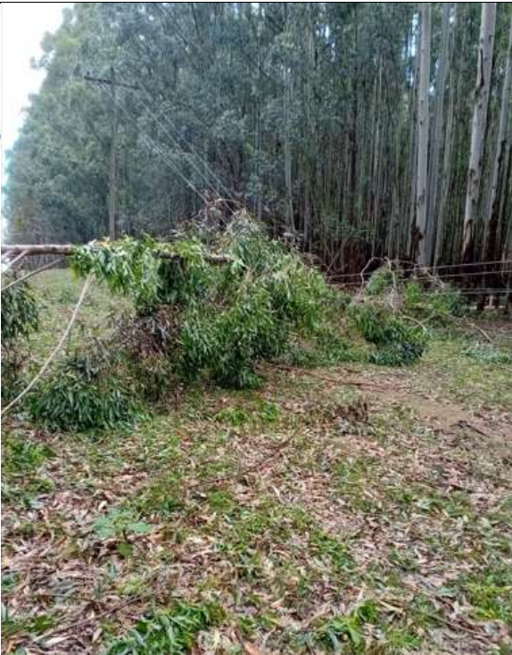
Foto 5 – Árvore caída sobre a rede devido ao evento em Candiota (2023-831764)
