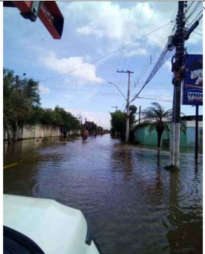
Foto 18 - Área alagada em Eldorado do Sul - ocorrência 2023-825728
