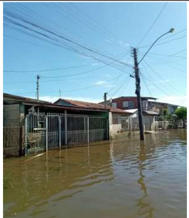
Foto 24 - Área alagada em Eldorado do Sul – ocorrência 2023-826339
