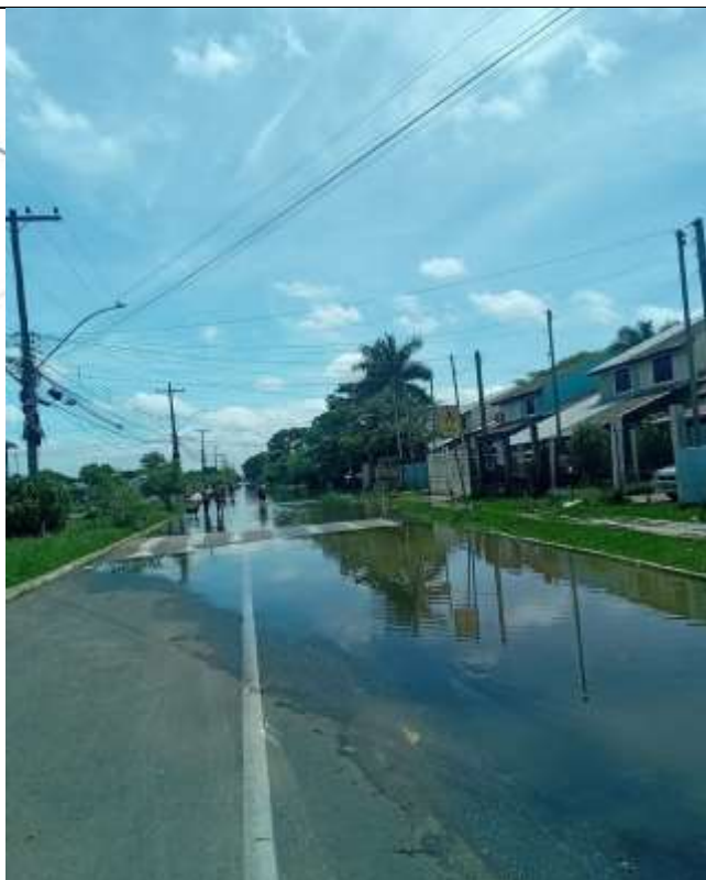
Foto 29 – Área alagada em Eldorado do Sul – ocorrência 2023-826949
