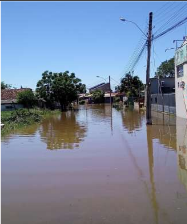
Foto 11 - Área alagada em Eldorado do Sul - ocorrência 2023-825649
