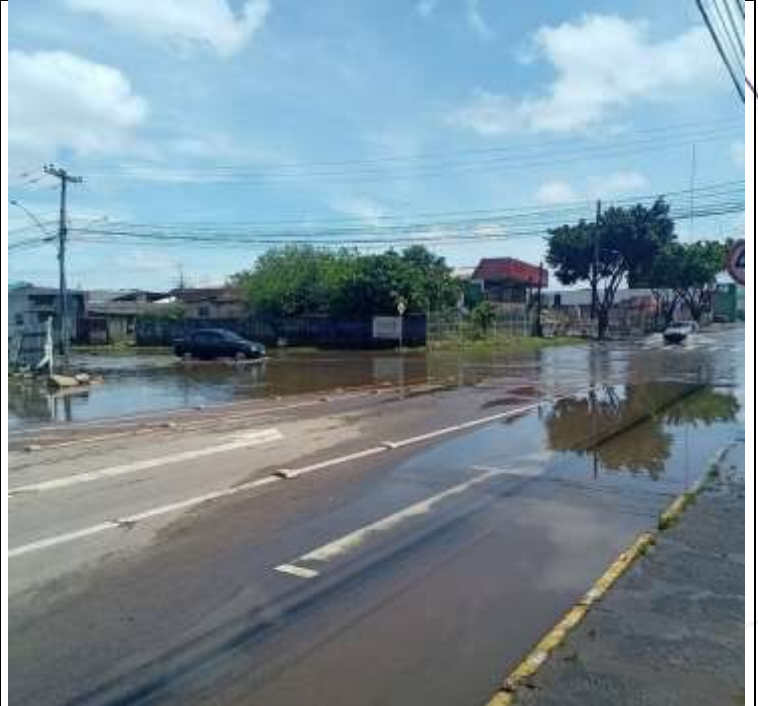
Foto 26 - Área alagada em Eldorado do Sul – ocorrência 2023-826519
