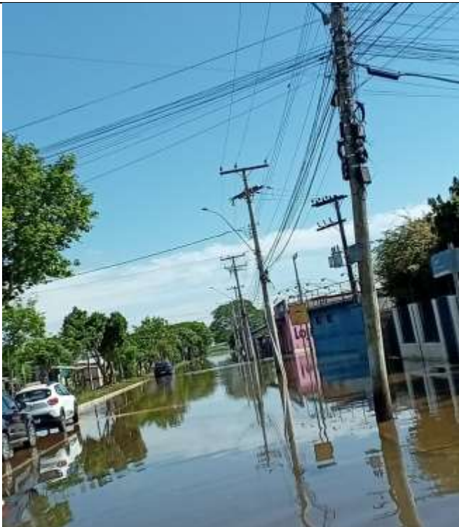
Foto 7 – Área alagada em Eldorado do Sul – ocorrência 2023-825508
