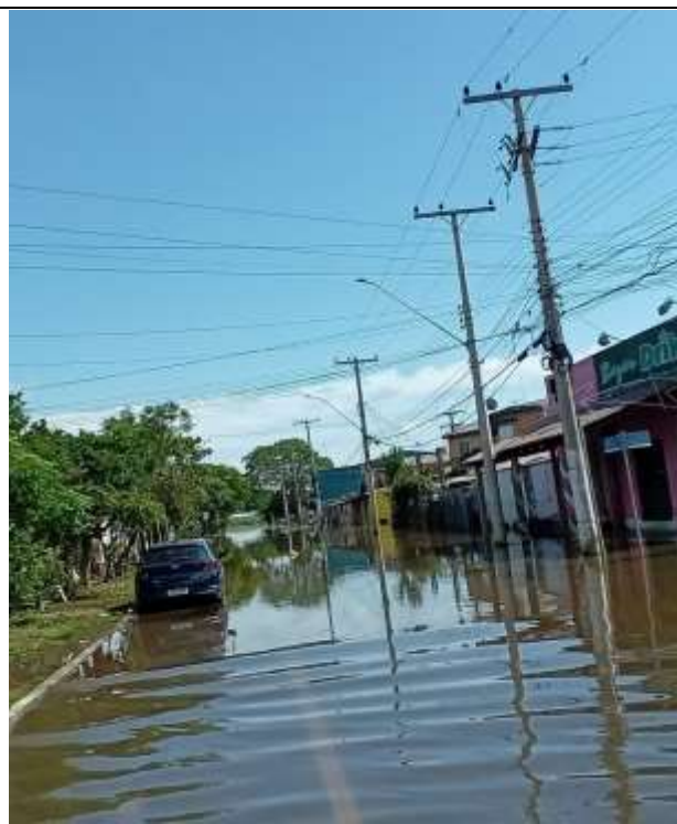
Foto 4 - Área alagada em Eldorado do Sul - ocorrência 2023-825507
