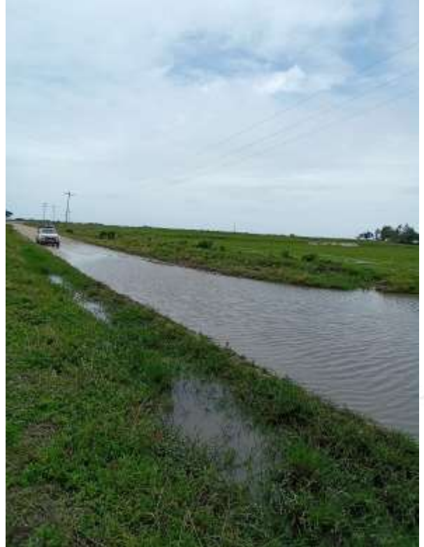
Foto 2 - Estrada alagada, dificultando o acesso, em Mostardas - RS
