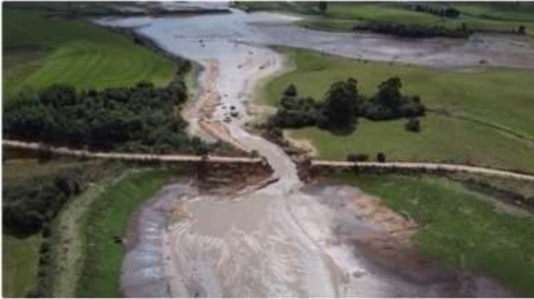
Dois barragens se rompem em Canguçu, no Rio Grande do Sul, após fortes chuvas
