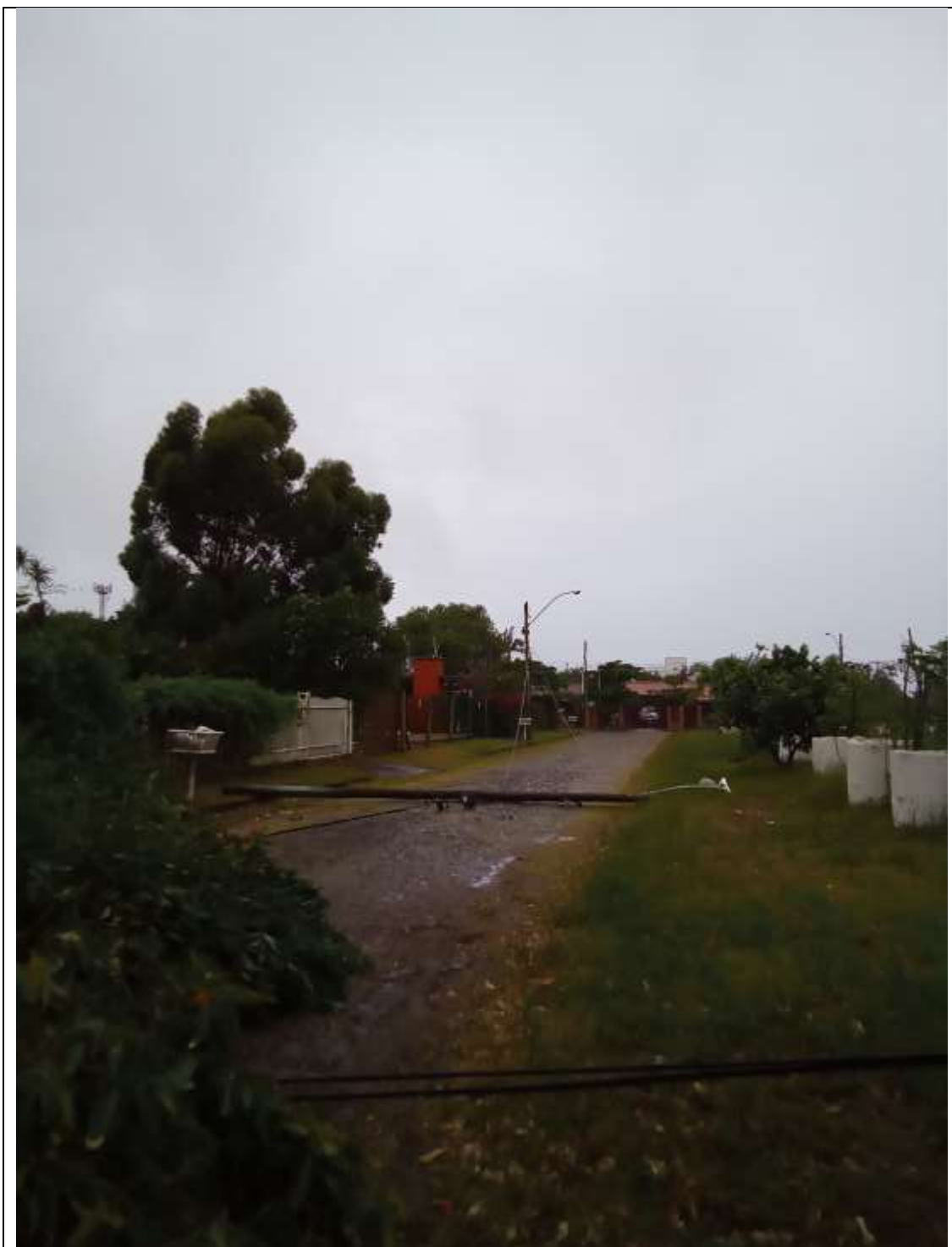
Foto 2 – Poste caído devido ao temporal em Capão da Canoa – RS
