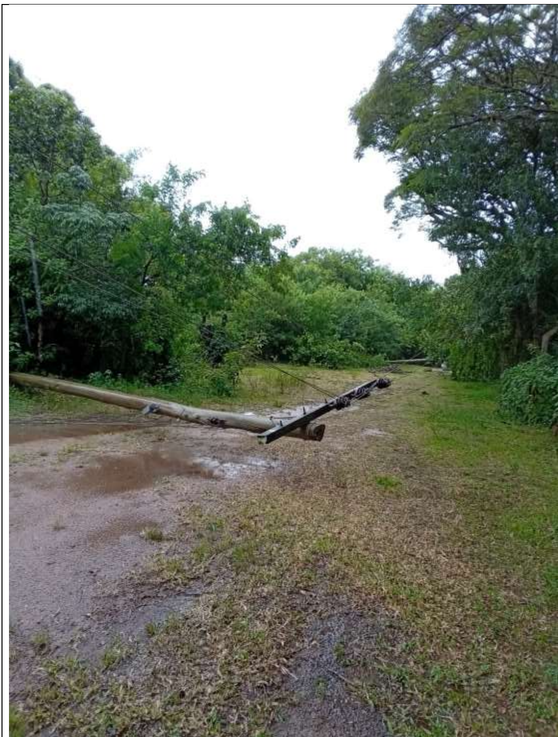
Foto 4 – Poste caído devido ao temporal em Camaquã - RS
