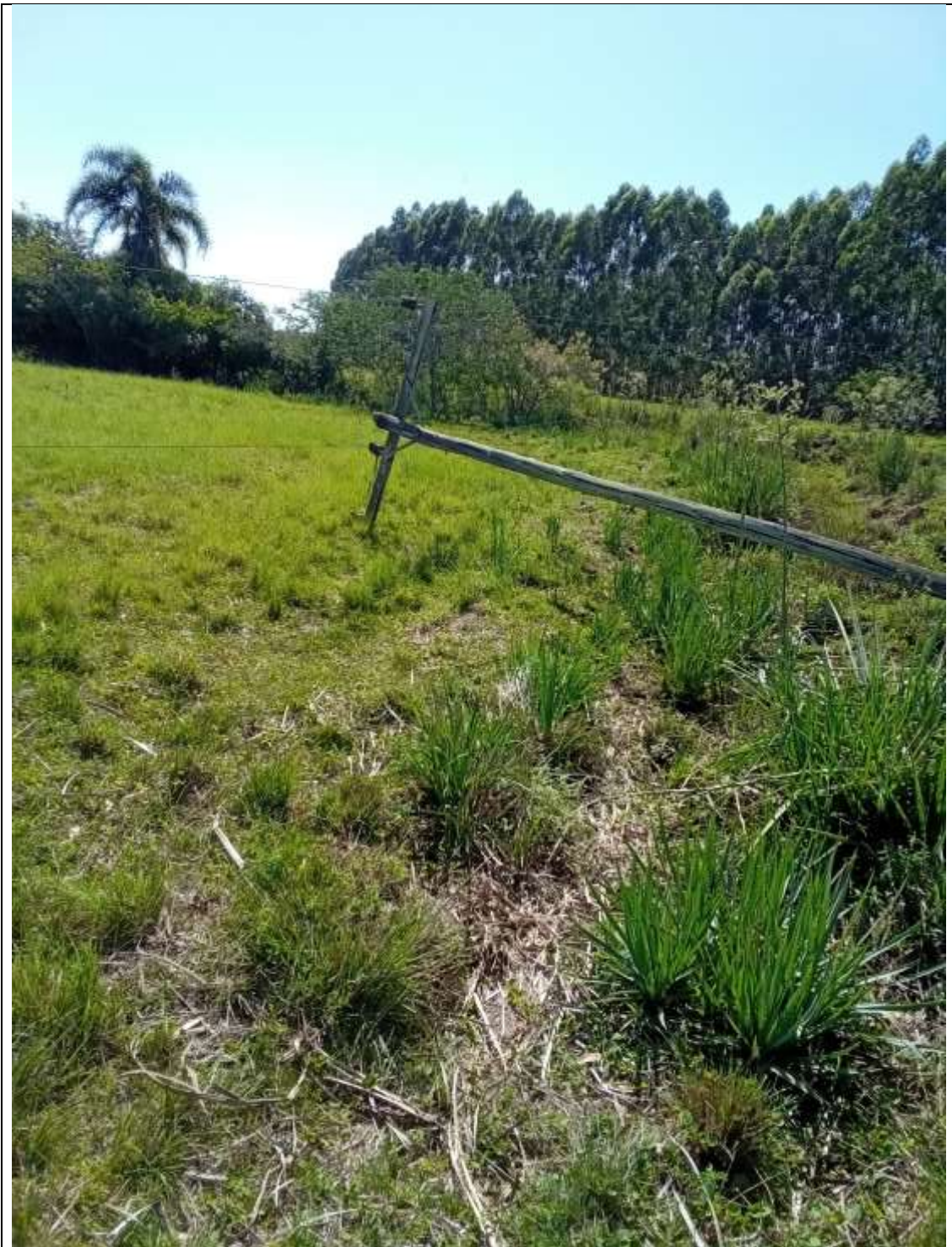
Foto 7 – Poste caído devido ao temporal em Eldorado do Sul – RS
