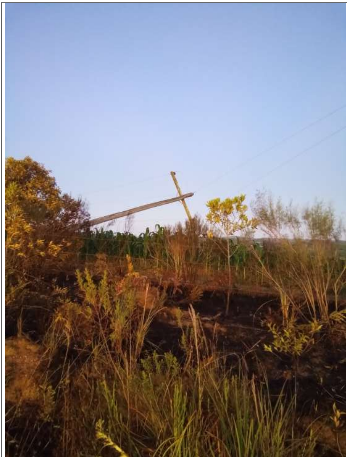
Foto 11 – Poste tombado devido ao temporal em Pelotas – RS
