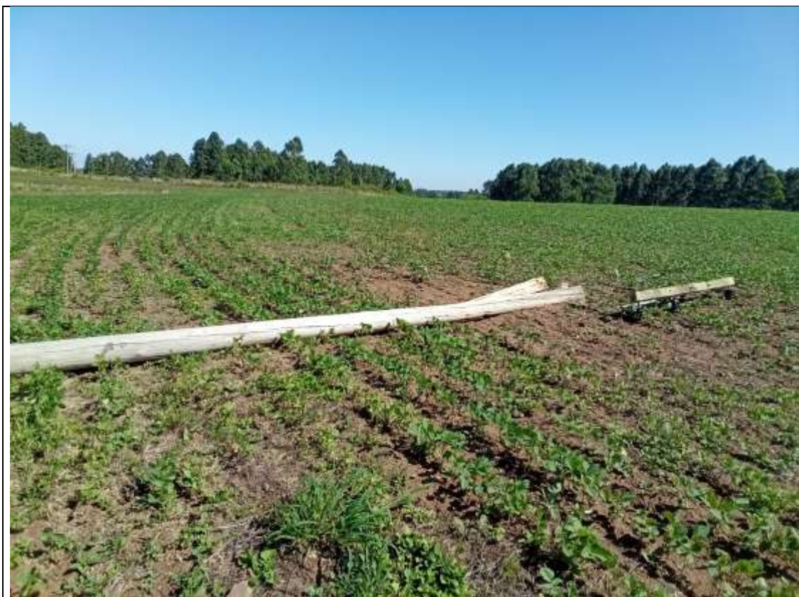
Foto 9 – Poste caído devido ao temporal em Eldorado do Sul – RS
