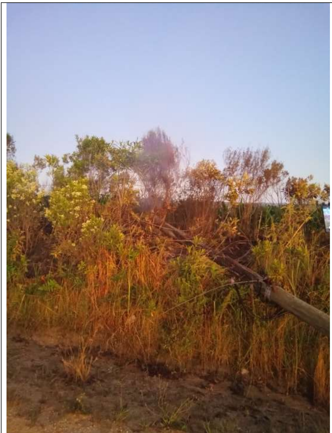
Foto 10 – Poste caído devido ao temporal em Pelotas – RS
