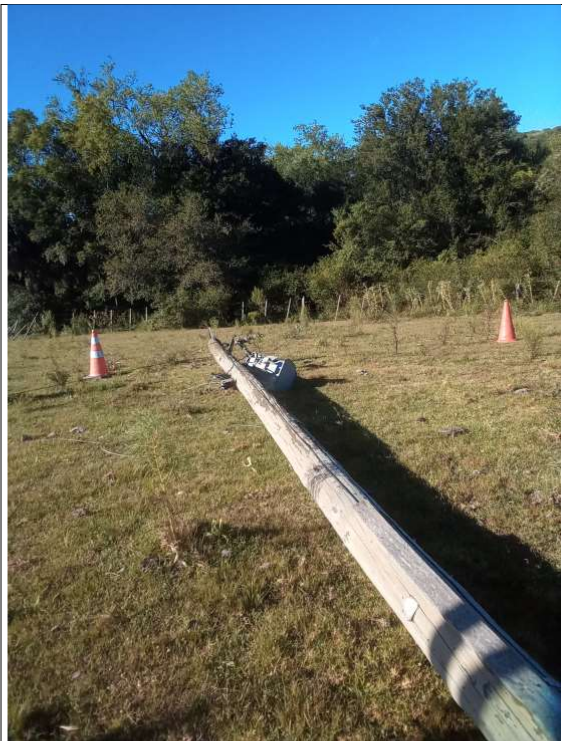
Foto 3 – Poste caído devido ao temporal em Canguçu – RS
