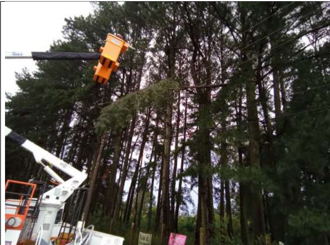
Foto 3 – Queda de galhos sobre a rede devido ao temporal em Candiota – RS
