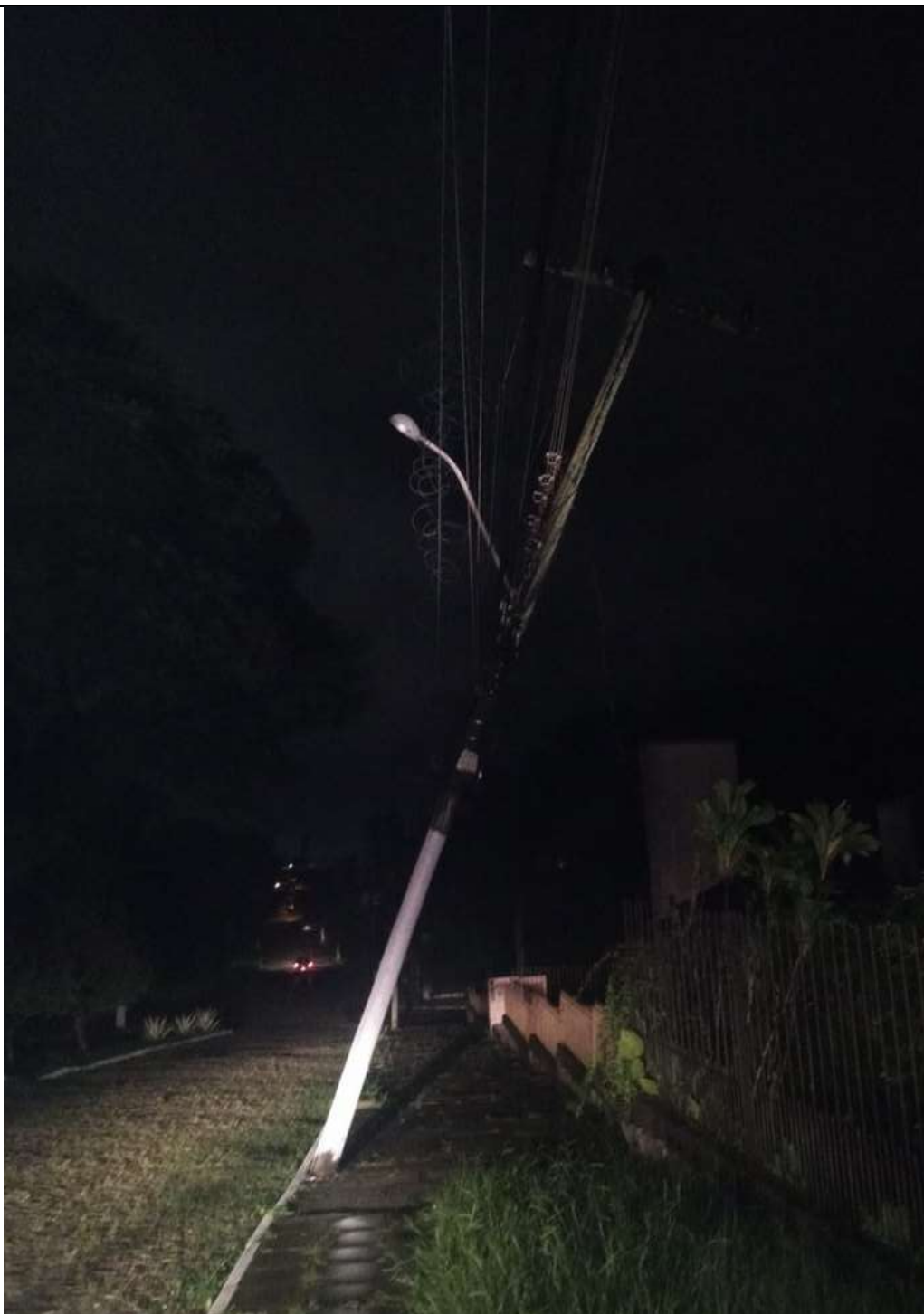
Foto 4 – Poste tombado devido ao temporal em Guaíba – RS
