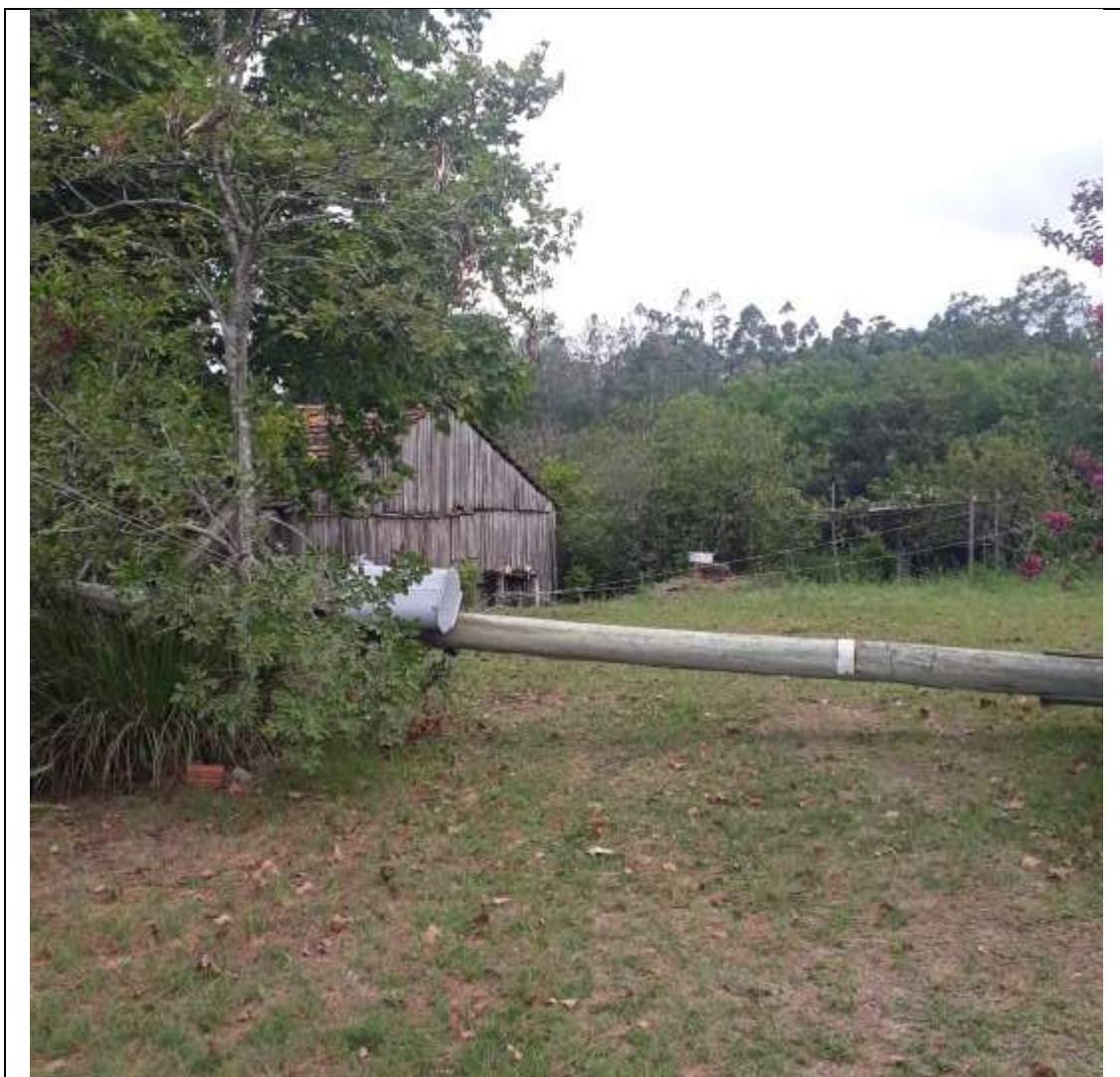
Foto 10 – Poste caído devido ao temporal em Pelotas – RS
