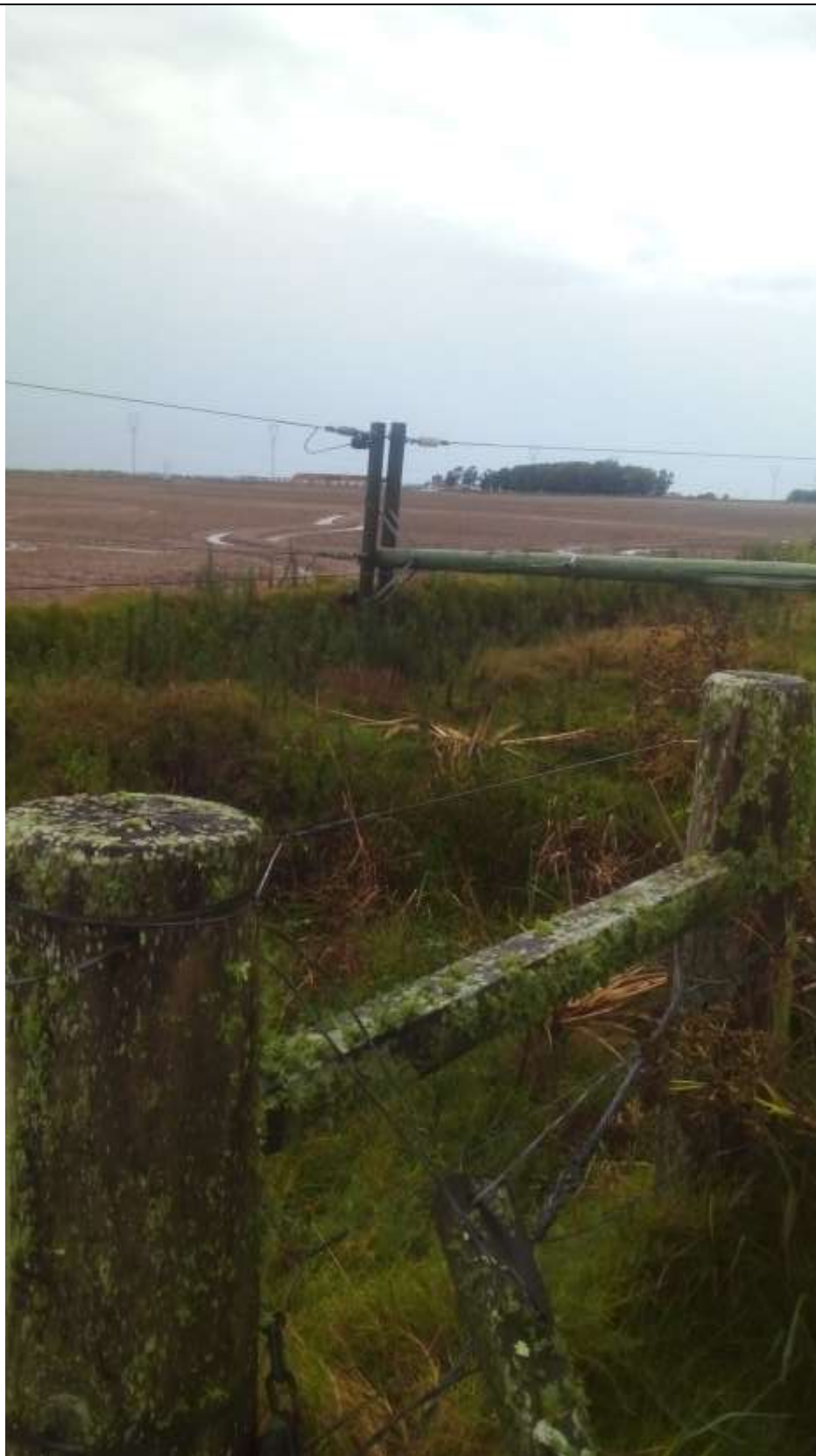
Foto 12 – Poste caído devido ao temporal em Rio Grande – RS
