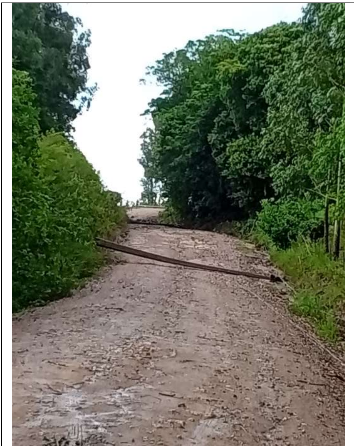
Foto 3 – Postes caídos devido ao temporal em Dom Feliciano – RS
