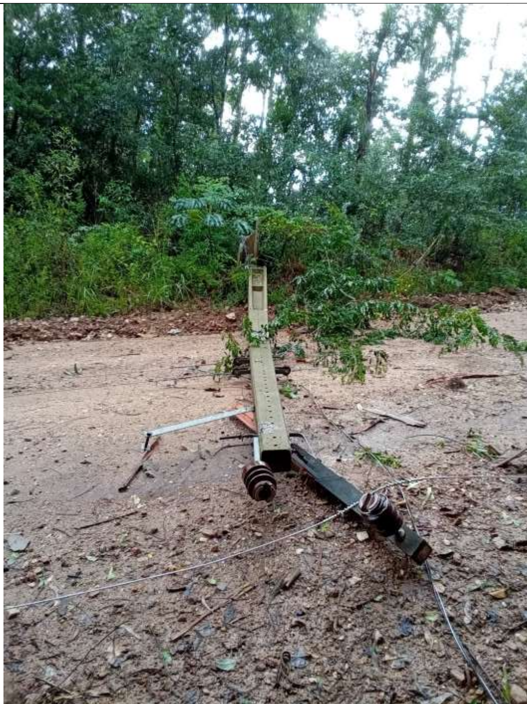
Foto 4 – Poste caído devido ao temporal em Dom Feliciano - RS
