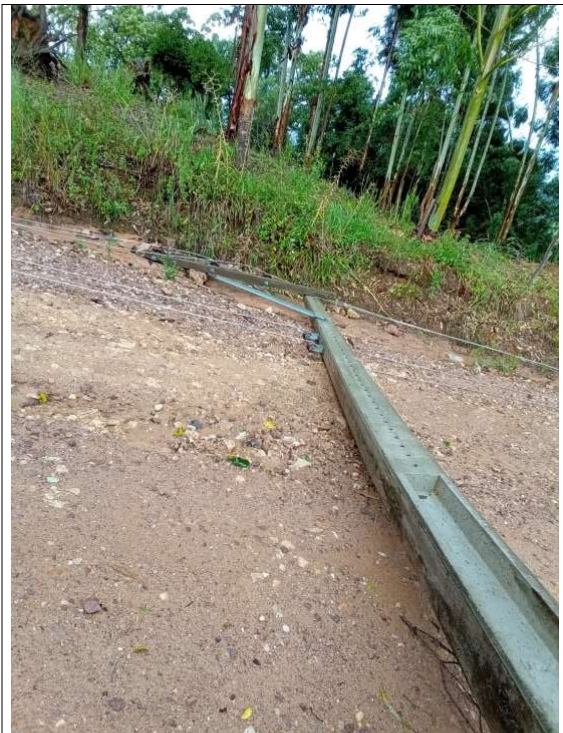
Foto 5 – Poste caído devido ao temporal em Dom Feliciano – RS
