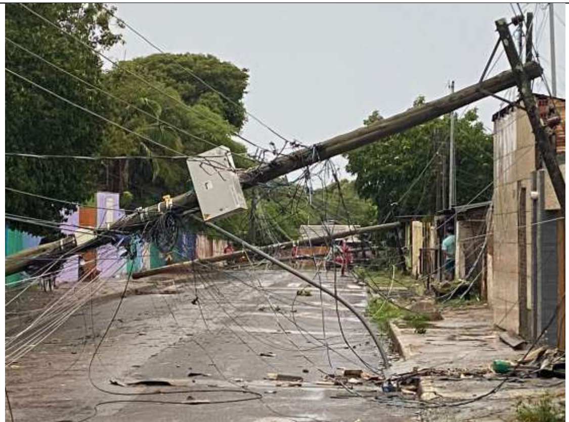
Foto 1 – Poste caído devido ao temporal em Porto Alegre – RS
