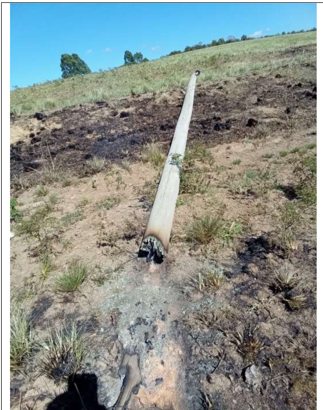
Foto 15 – Poste queimado devido ao temporal em Encruzilhada do Sul – RS
