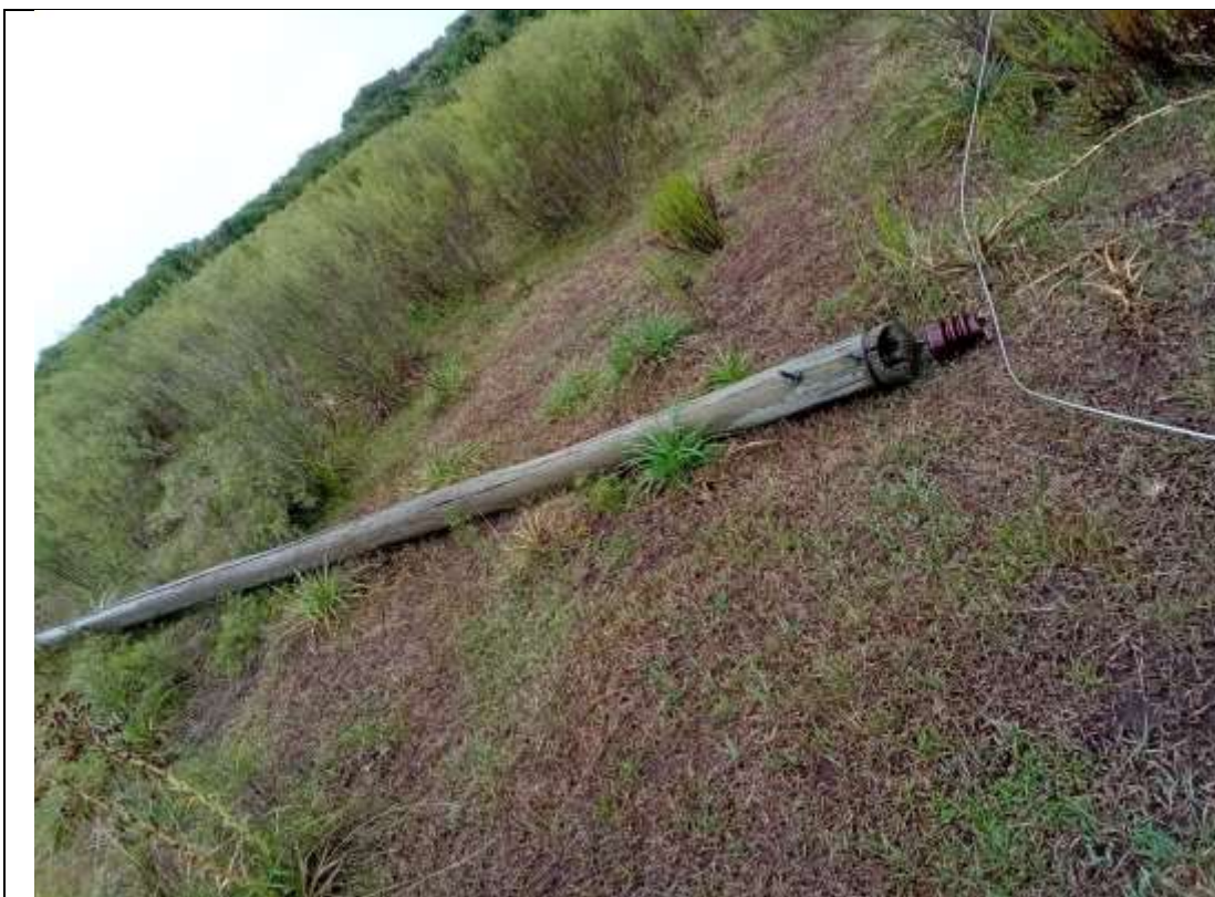
Foto 11 – Poste caído devido ao temporal em Pinheiro Machado – RS
