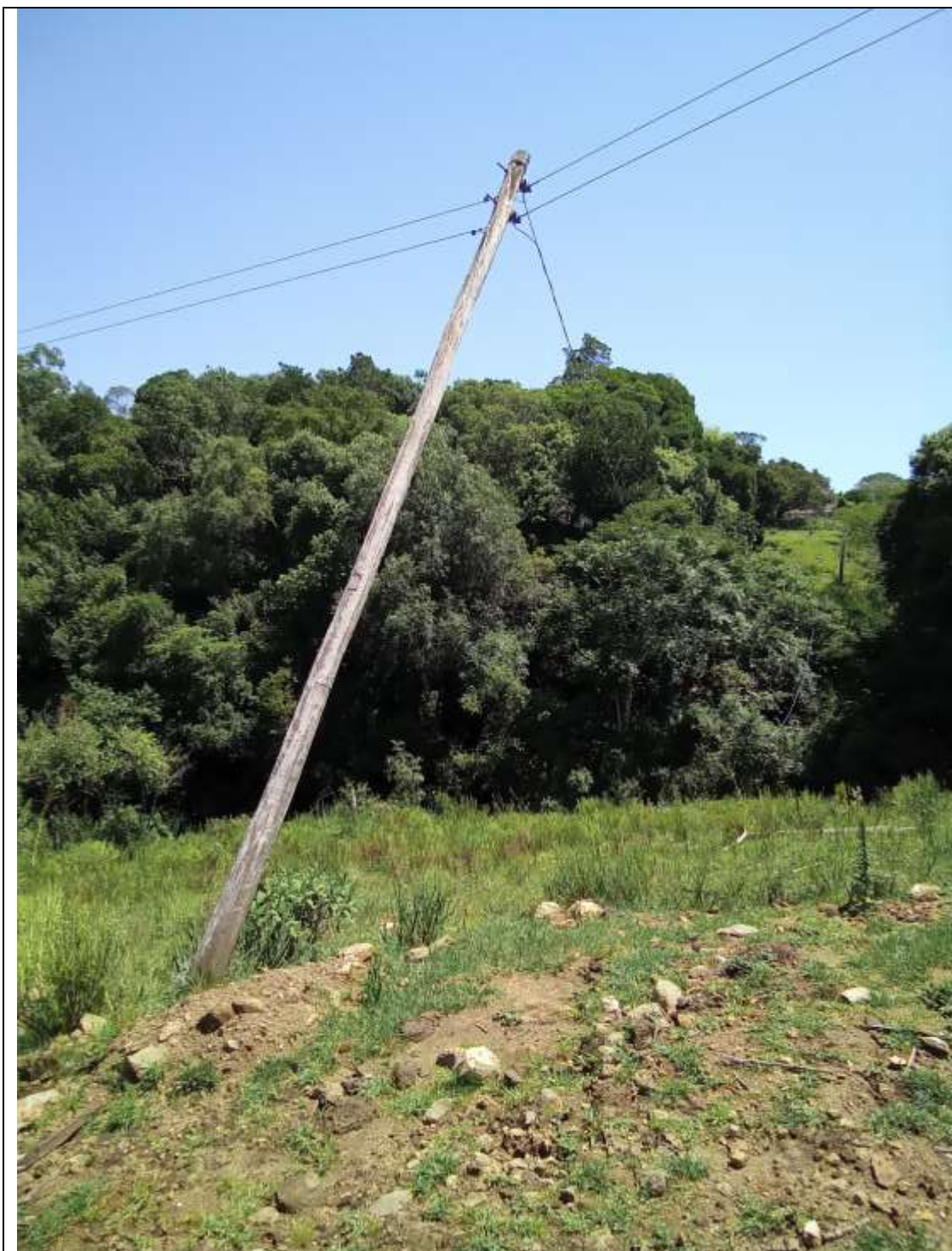
Foto 6 – Poste tombado devido ao temporal em São Lourenço do Sul – RS
