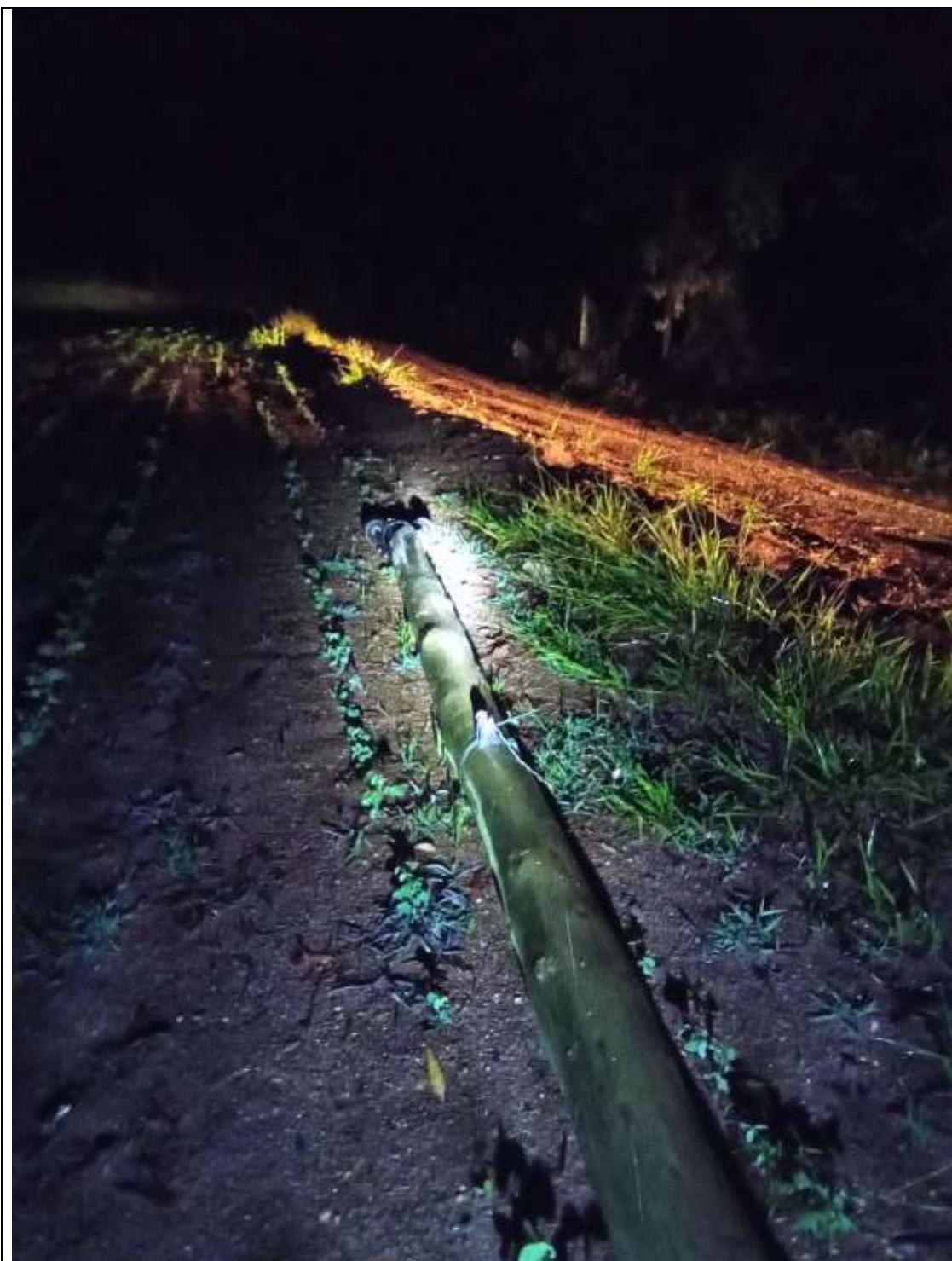
Foto 8 – Poste caído devido ao temporal em Sertão Santana – RS
