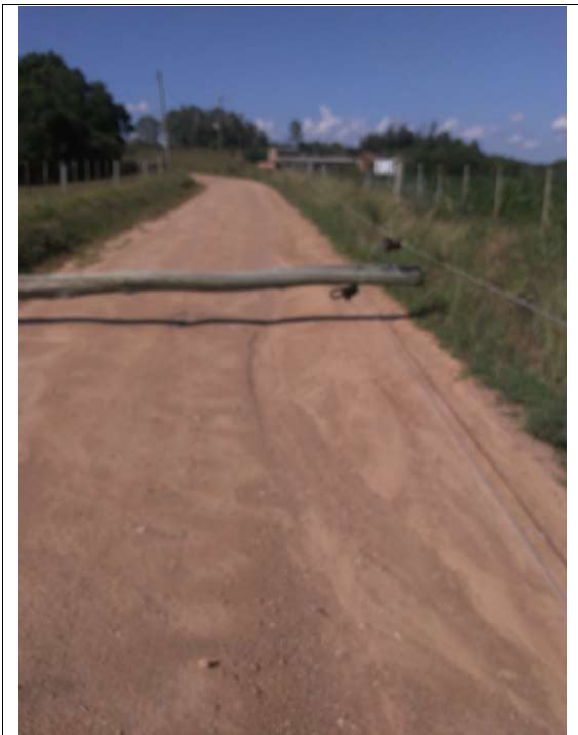
Foto 2 – Poste caído devido ao temporal em Canguçu – RS
