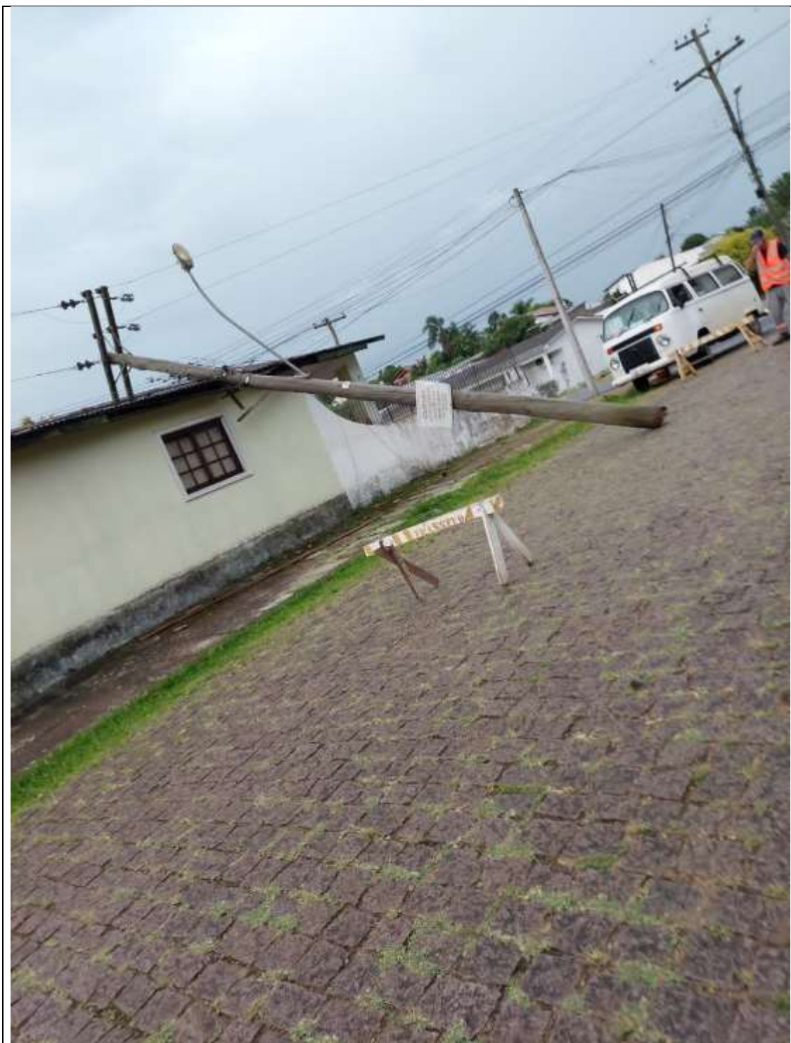
Foto 10 – Poste caído devido ao temporal em São Jerônimo – RS
