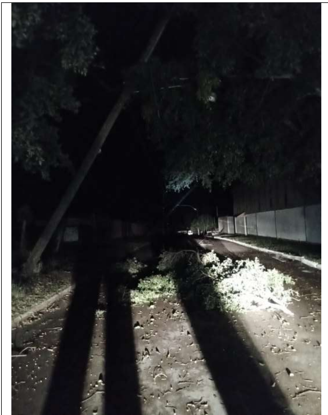
Foto 3 – Galhos no chão e postes tombados devido ao temporal em Charqueadas – RS
