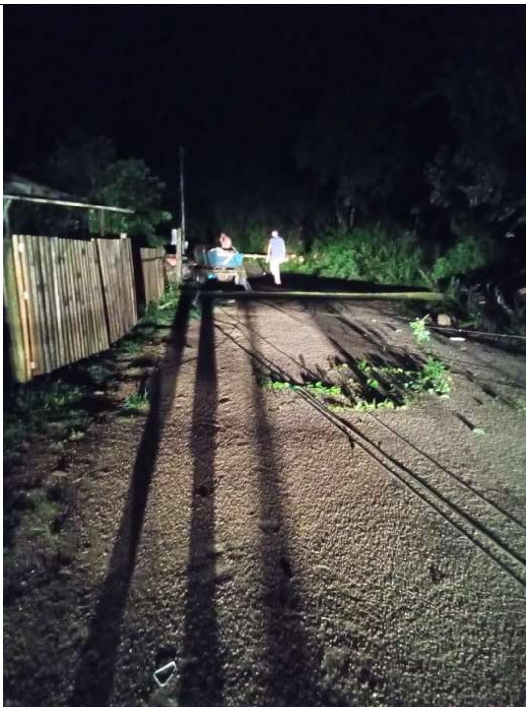
Foto 10 – Poste caído devido ao temporal em Cerro Grande do Sul – RS
