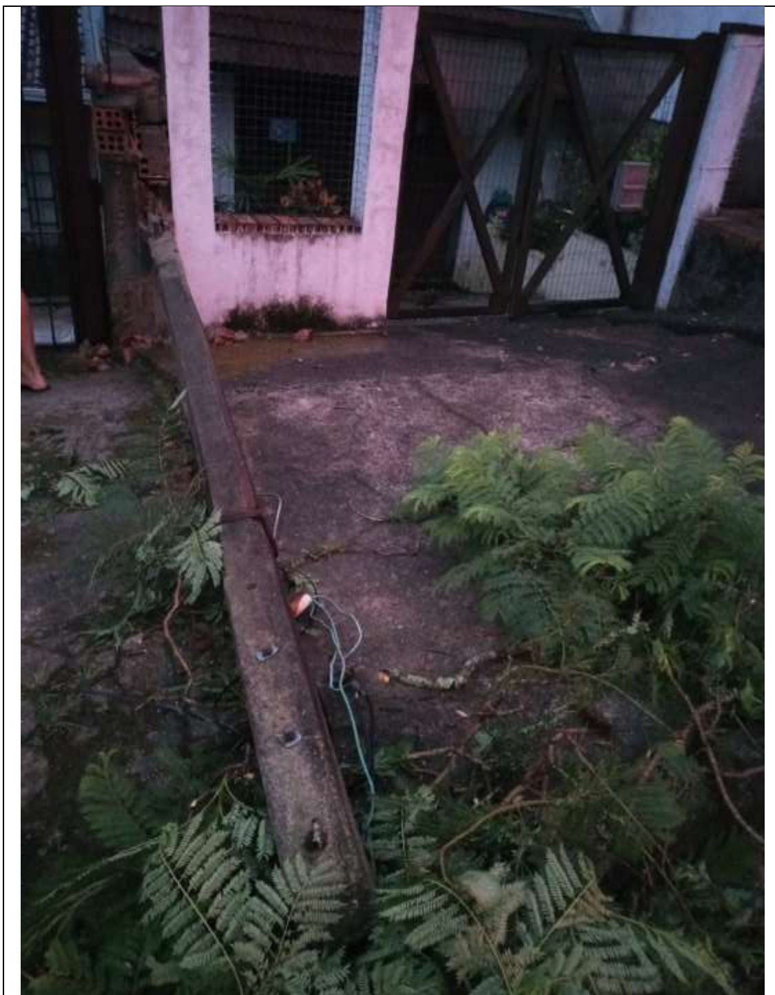
Foto 2 – Poste caído devido ao temporal em Porto Alegre – RS
