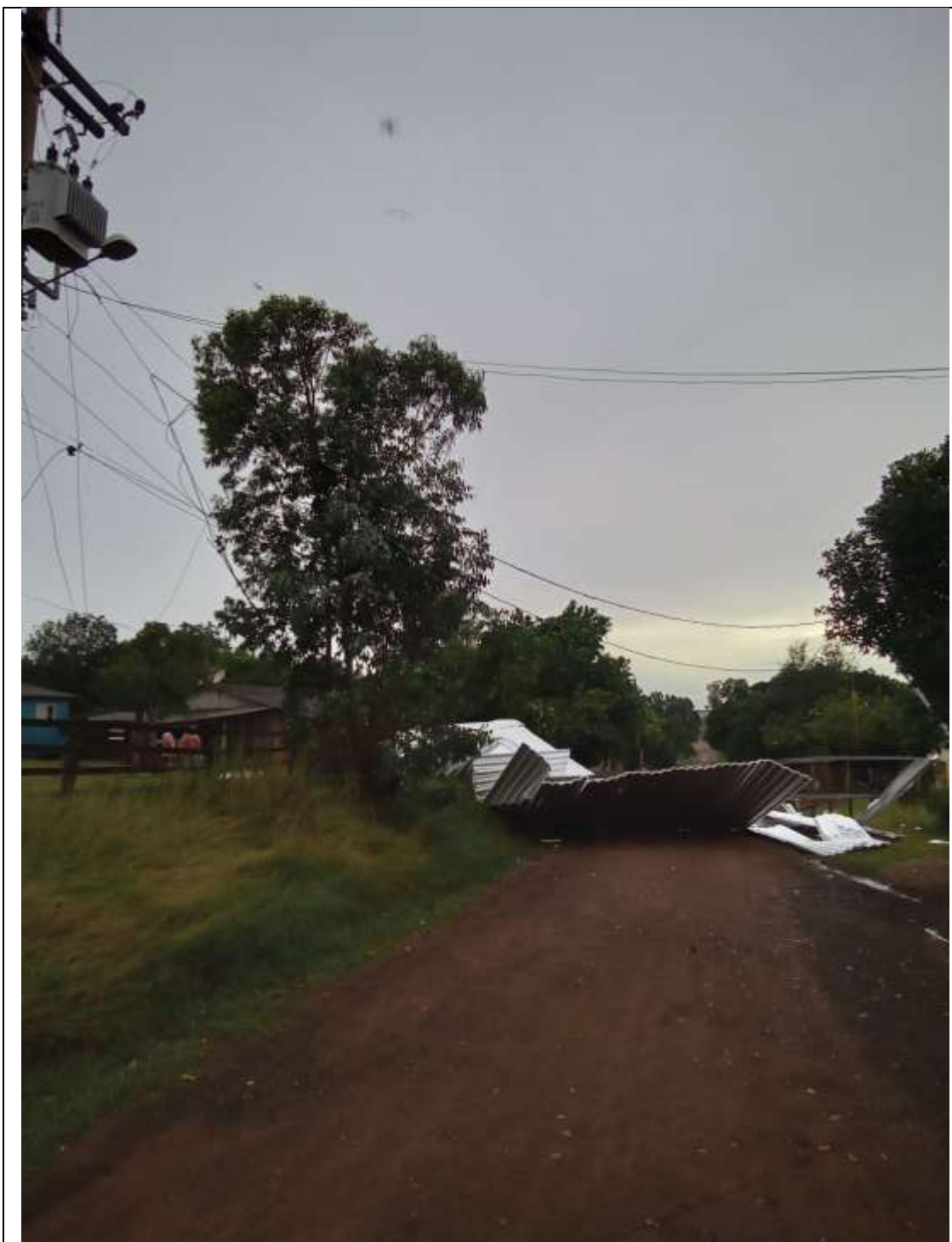
Foto 7 – Telhado caído devido ao temporal, atingindo a rede elétrica, em São Jerônimo – RS
