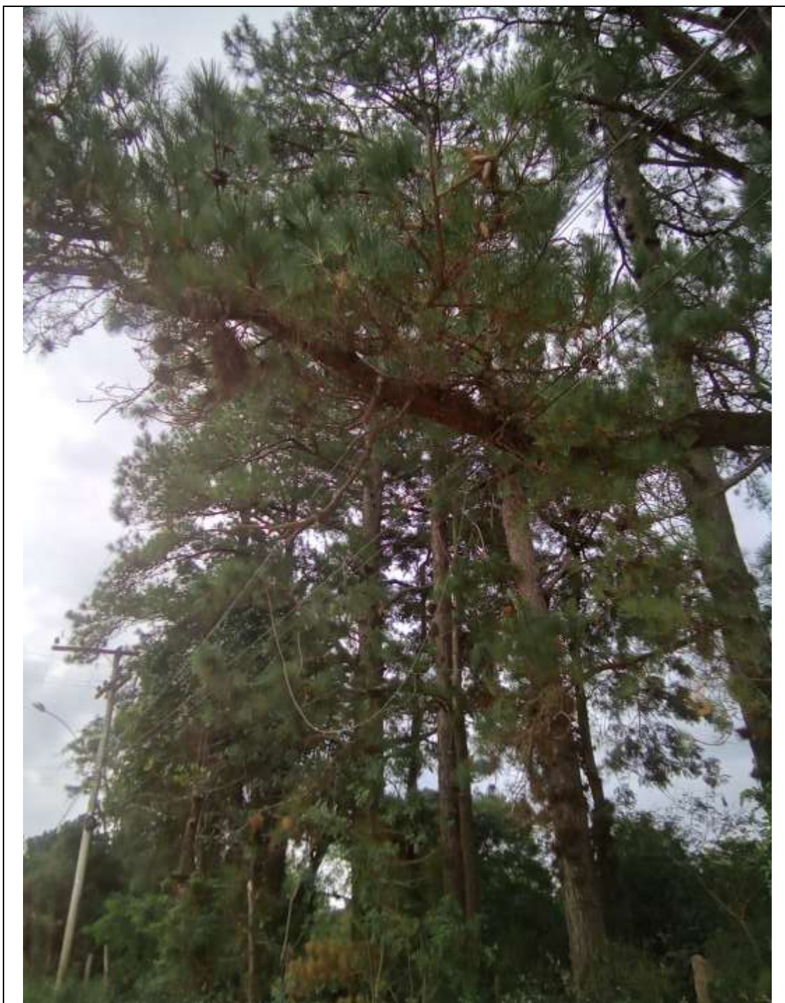
Foto 8 – Árvore caída sobre a rede devido ao temporal em Guaíba – RS
