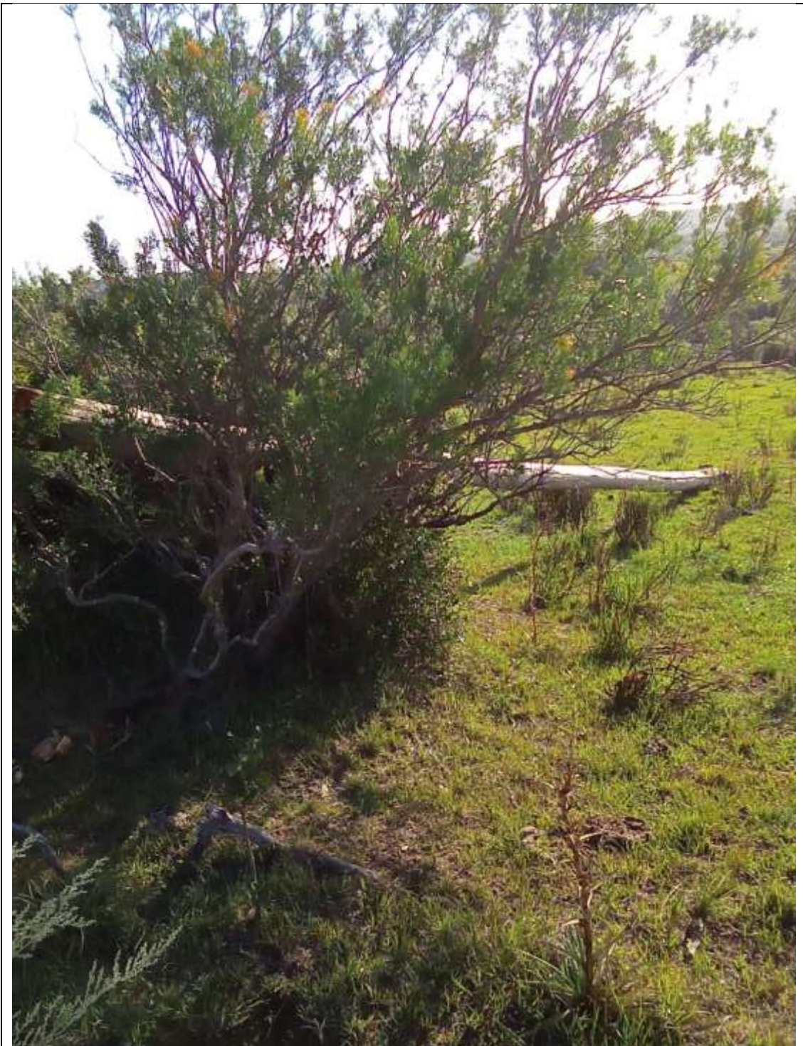
Foto 6 – Poste caído devido ao temporal em Herval – RS
